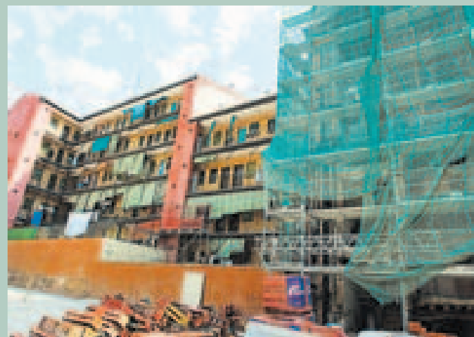
Obras de rehabilitación en un edificio de Madrid.
