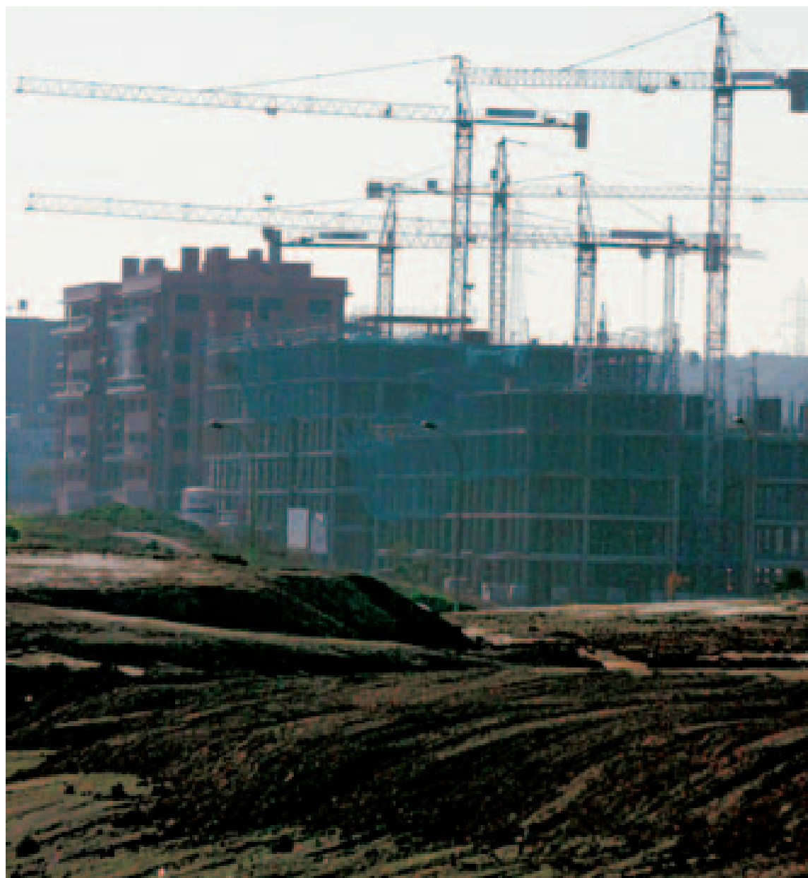
Viviendas en construcción en los nuevos desarrollos de Getafe.
