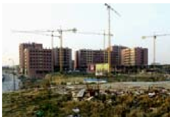
Viviendas en construcción en Vicálvaro.
