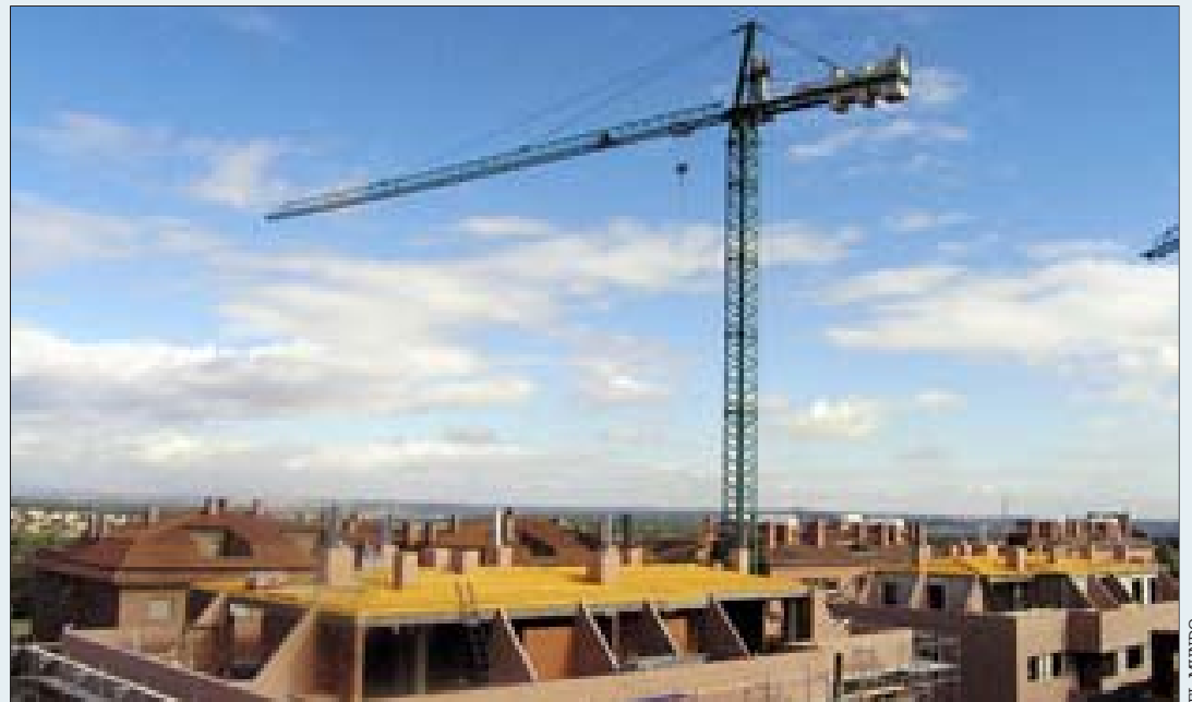
En la imagen, una grúa entre unas viviendas en construcción.
