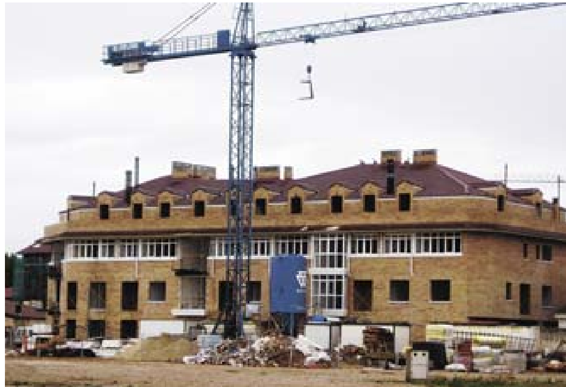
Una de las múltiples obras de nuevas viviendas que se están llevando a cabo en la localidad.
