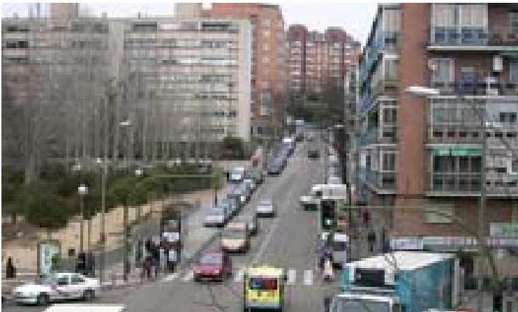
Vista general de la calle de Cebreros, en el barrio de Lucero.
