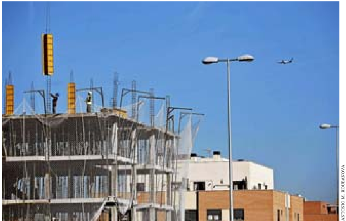
Imagen de las obras de construcción en el municipio de Arganda del Rey.
