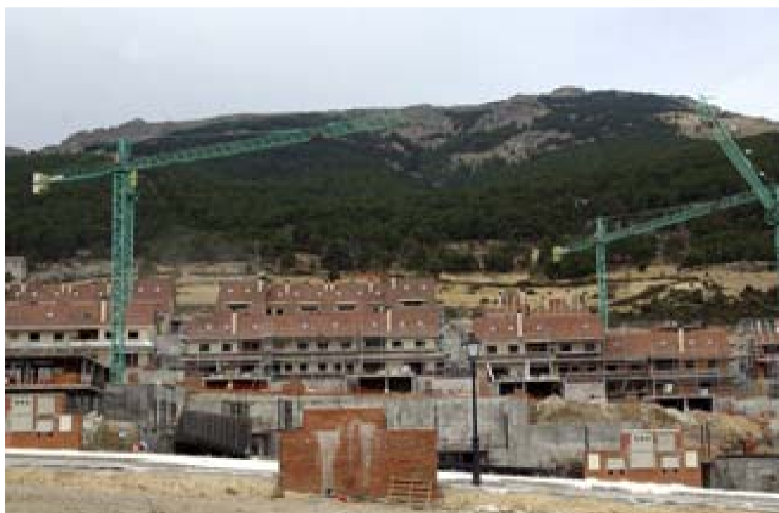
Imagen de viviendas en construcción en el municipio de El Escorial.
