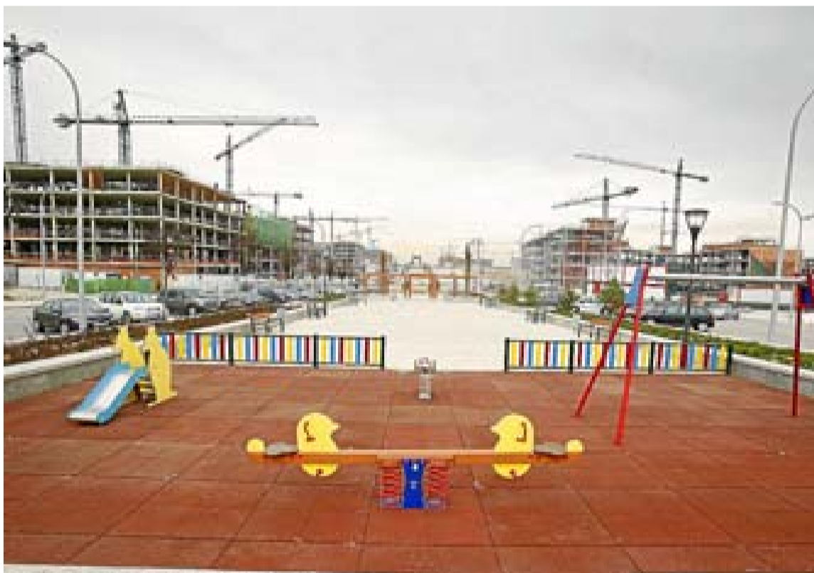
Zona de Alcobendas donde están construyéndose las promociones de viviendas.
