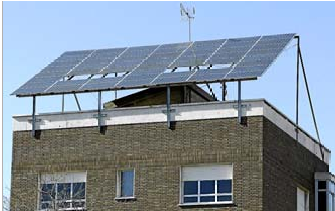
Vivienda con paneles solares, en Madrid. / JULIÁN JAÉN
