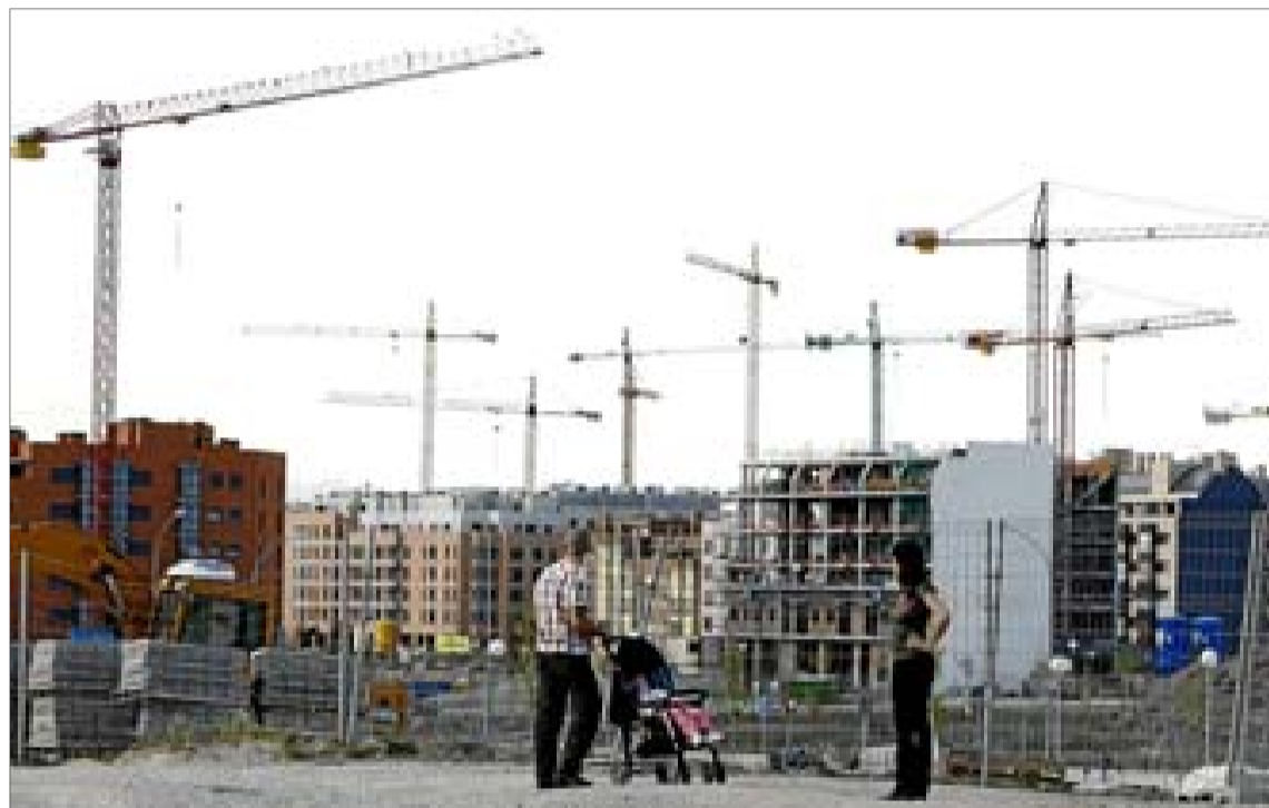
Viviendas en construcción, en el Ensanche de Vallecas. / ANTONIO HEREDIA
