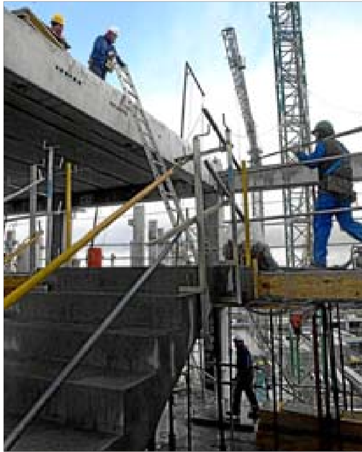
Construcción de Viviendas de Protección Oficial en Vitoria. / MITXI
